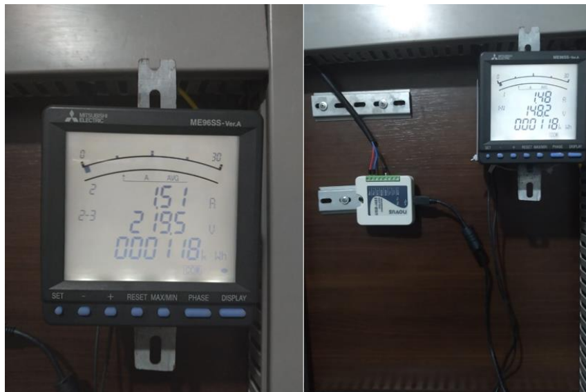
Figura 3 – Multimetro ME96SS instalado no painel juntamente com o conversor I485
