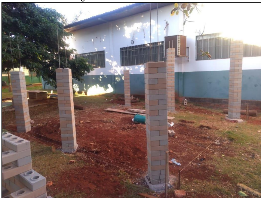
Figura 2: Pilares de solo-cimento
