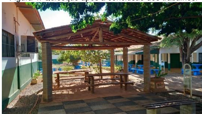
Figura 4: Quiosque após a conclusão dos trabalhos.
