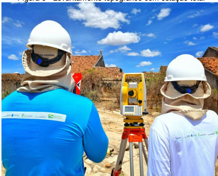
Figura 9 - Levantamento topográfico com estação total
