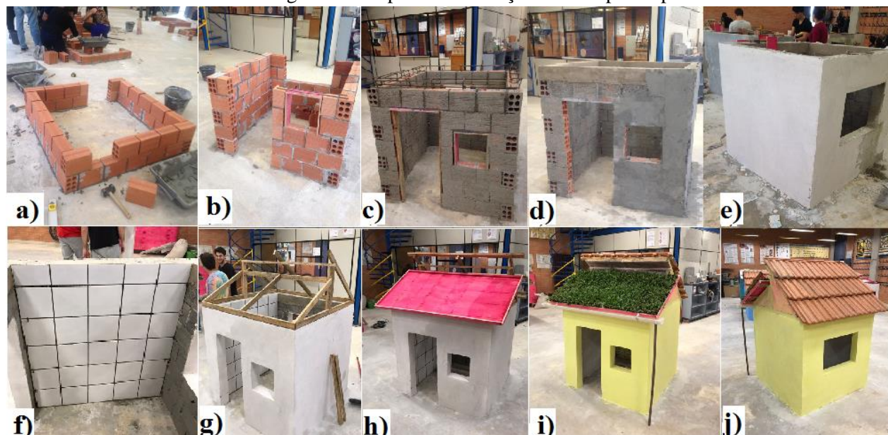
Figura 4 – Etapas da construção da casa protótipo.
