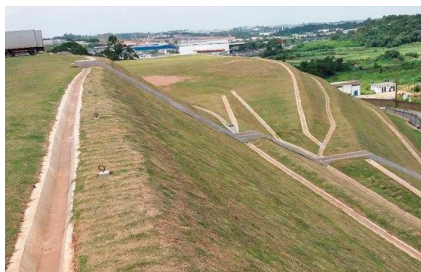
Figura 3: Obras de proteção de taludes com uso de plantio de grama, associado a um efetivo sistema de drenagem.
