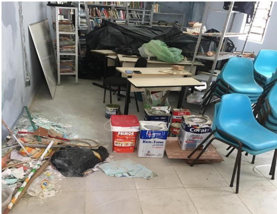
Figura 2 – Espaço onde se realizava o projeto antes da reforma.
