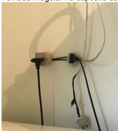
Figura 1: Tomada irregular no depósito de alimentos
