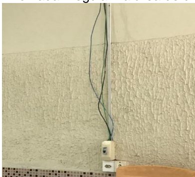
Figura 2: Tomada irregular na área de circulação.
