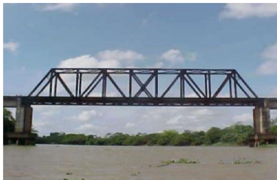
Figura 6 – Ponte ferroviária real.
