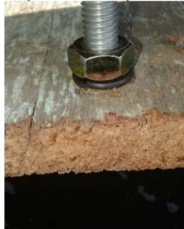
Figura 8- Fixação das barras de aço na base da madeira.
