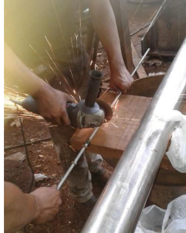
Figura 5 – Procedimento de corte das barras de aço.
