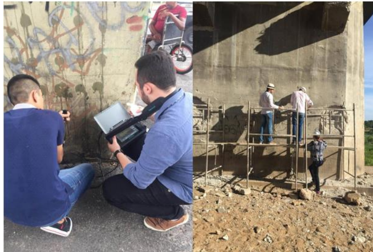
Figura 1- END em viadutos de Fortaleza-CE
