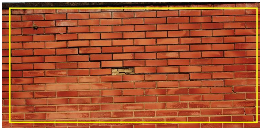
Figura 9 –Inspeção visual da parede lateral no alto da edificação. Descolamento do revestimento.
