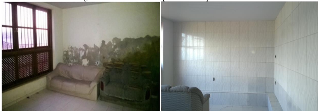
Figura 1 - Sala 1 do CCBP pré reforma e pós reforma.
