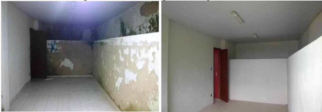
Figura 2 - Sala 2 do CCBP pré reforma e pós reforma.
