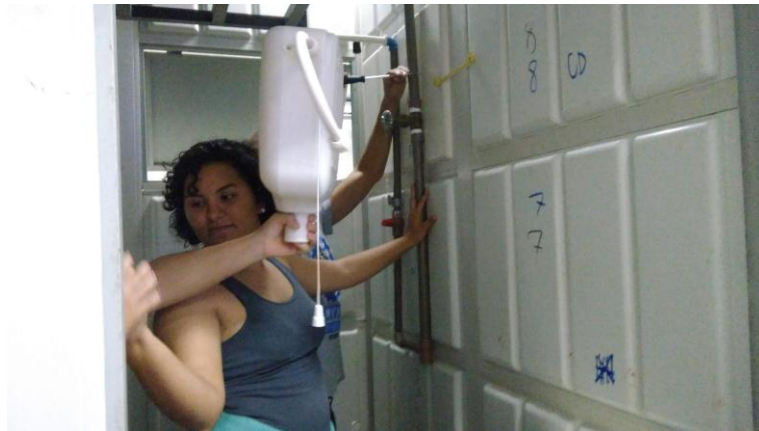
Figura 4: Estudos dos tempos produtivos na montagem do banheiro de plástico reciclado
