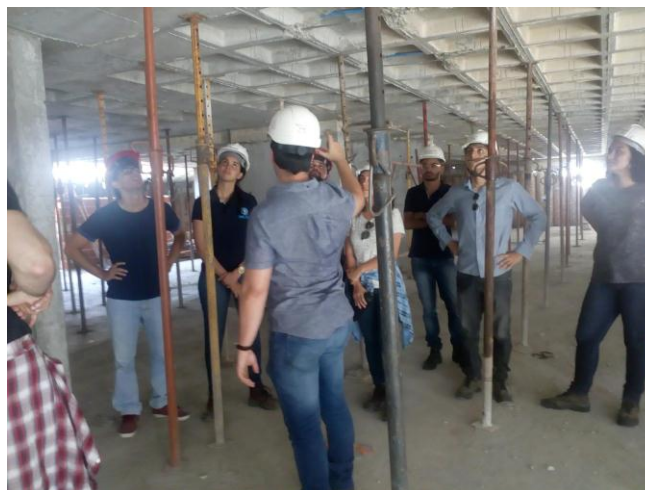
Figura 1 – Visita técnica realizada na obra para estudar laje protendida
