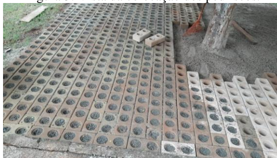
Figura 5: Vista da colocação dos pedriscos.
