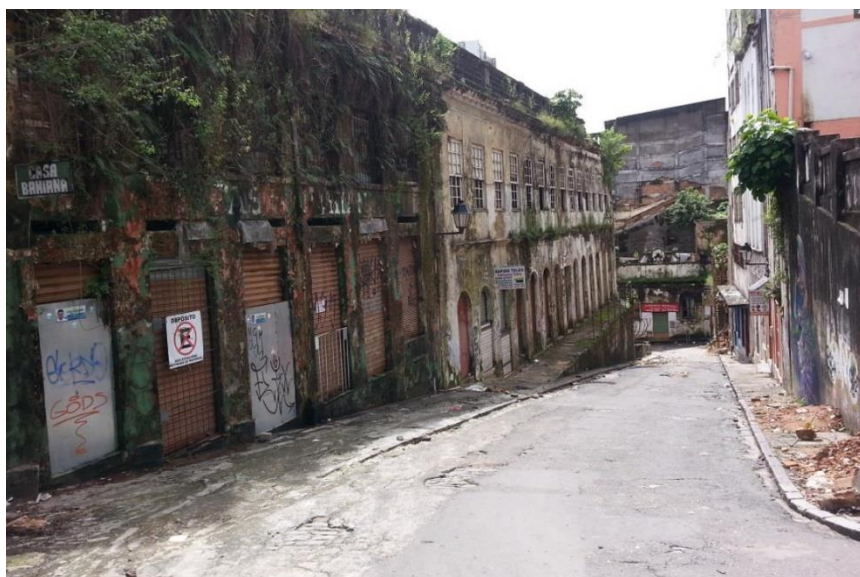
Figura 1 – Rua do Centro Antigo completa de prédios abandonados.
