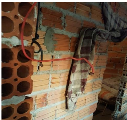
Figura 9 – Fiação exposta.
