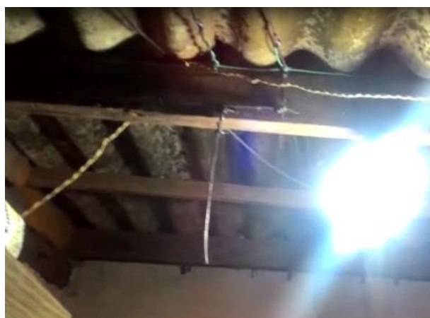
Figura 5 – Fios desencapados e com muitas emendas.
