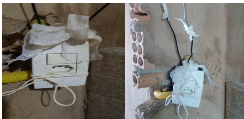
Figura 6 – Tomada e interruptor presos por fio.
