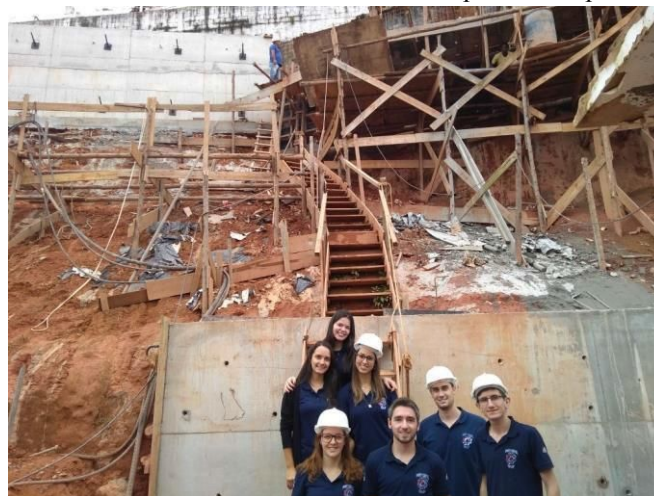
Figura 6 – Visita Técnica em obra de Cortina Atirantada promovida pelo PET Civil UFJF.
