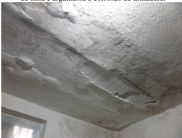
Figura 3 - Teto de banheiro com infiltrações, deslocamento de tinta e argamassa e corrosão de armadura.
