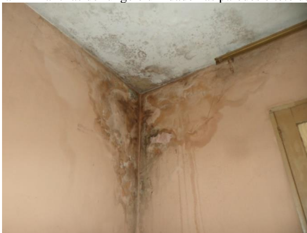
Figura 1 - Manchas de fungo e umidade nas paredes e teto da sala.
