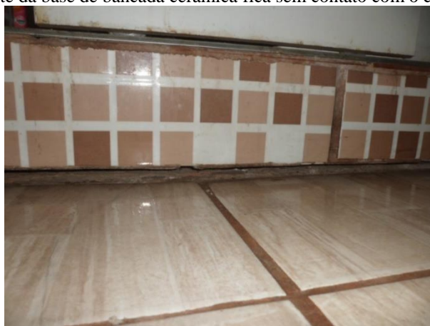
Figura 6 - Como consequência do afundamento do piso, parte da base de bancada cerâmica fica sem contato com o chão.
