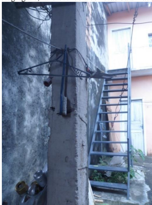
Figura 4 - Pilar de área externa com parte do concreto desagregado, favorecendo a corrosão da armadura.
