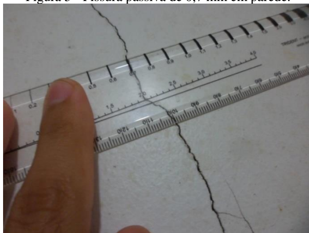
Figura 5 - Fissura passiva de 0,7 mm em parede.
