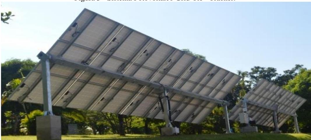
Outro sistema instalado no campus é um sistema *Off-Grid* (desconectado da rede elétrica da concessionária) de potência de 2,195 kWp que é utilizado para iluminação externa do andar inferior do prédio D (prédio do Laboratório de Elétrica e Mecatrônica). A disposição desse sistema pode ser visualizada na Figura 1, que está instalado em cima do eletrocentro e entre os sistemas fixo e *tracker*.
