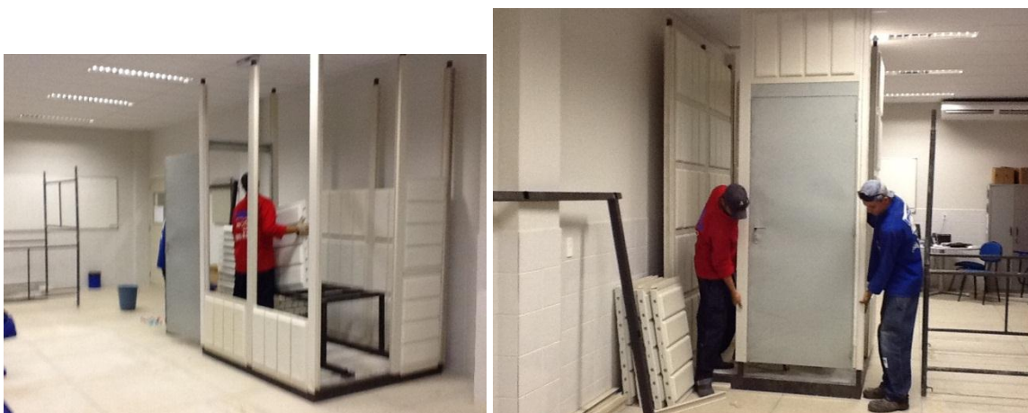
Figura 3 – Colocação da viga metálica superior – andaimes sem tábuas.
