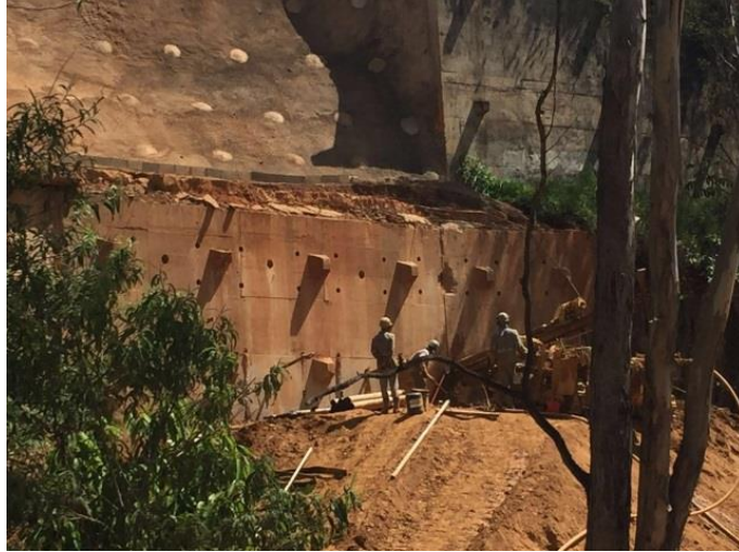
Figura 1- Execução da cortina atirantada
