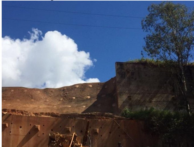
Figura 2- Vista cortina atirantada
