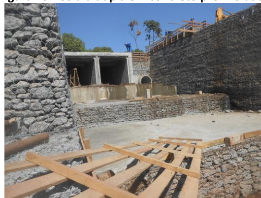
Figura 13 - Célula dupla em concreto pré-moldado
