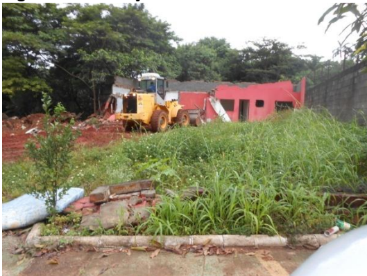
Figura 9 - Demolição das casas em área de APP
