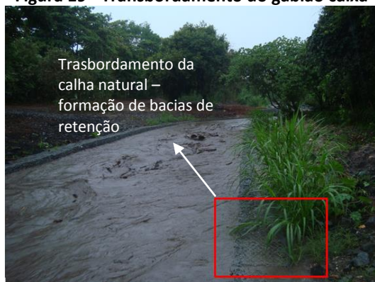
Figura 19 - Transbordamento do gabião caixa
