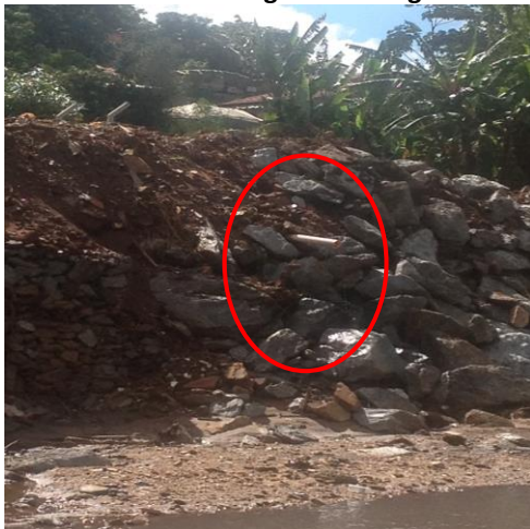
Figura 11 - Descarte de Esgoto - Córrego Macambira
