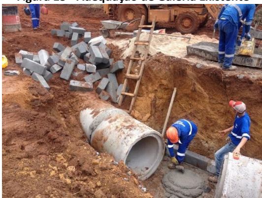
Figura 15 - Adequação de Galeria Existente
