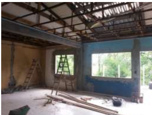
Figura 3 - Sala de estar
