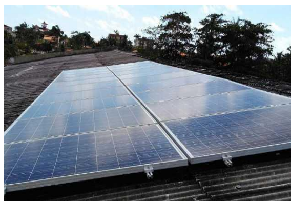
Figura 2 – Sistema fotovoltaico instalado na cobertura da escola.
