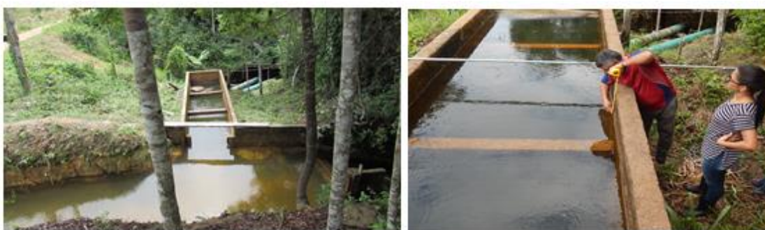
Figura 3: Sistema de adução. (a) vista desde o canal de adução até o conduto forçado. (b) câmara de carga com vistas para o conduto forçado. FONTE: Próprio autor.
