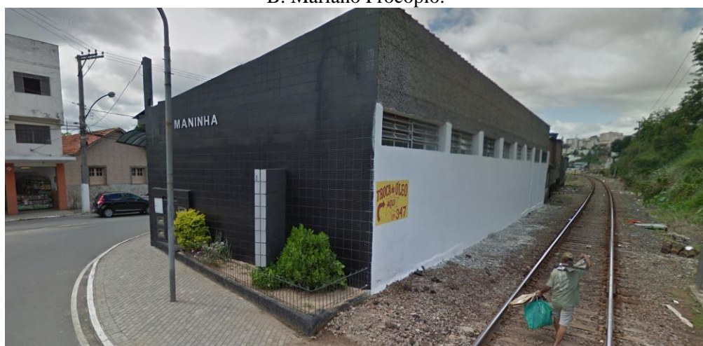
Figura 6 – Edificação comercial existente na faixa de domínio próximo a via Tereza Cristina, B. Mariano Procópio.
