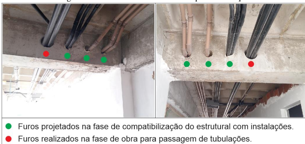
Figura 4 – Necessidade do furo na etapa de execução.
