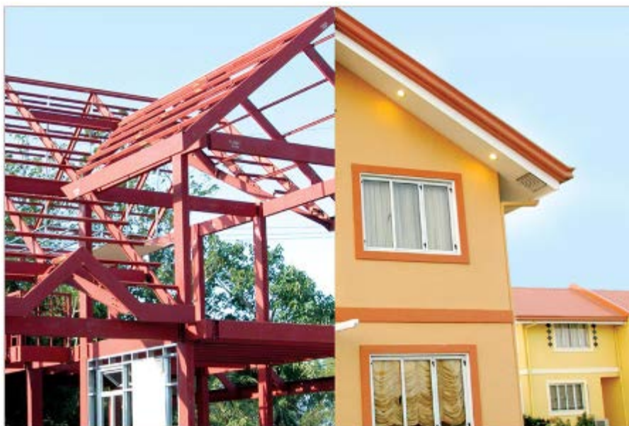
Figura 1 – Construção em sistema Steel Frame
