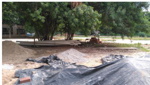
Figura 1 – Armazenagem de materiais.
