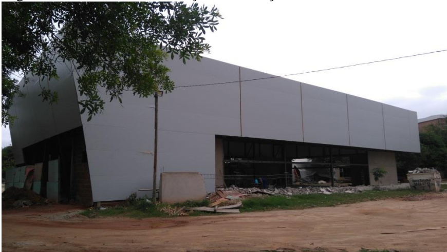
Figura 5 – Resíduos de construção e demolição na área externa da obra.
