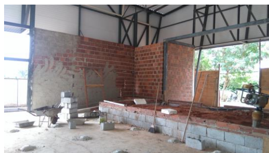
Figura 2 – Execução do auditório.
