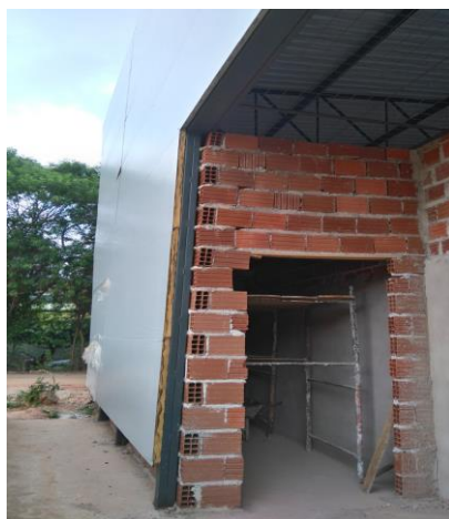
Figura 6 – Utilização de andaime.
