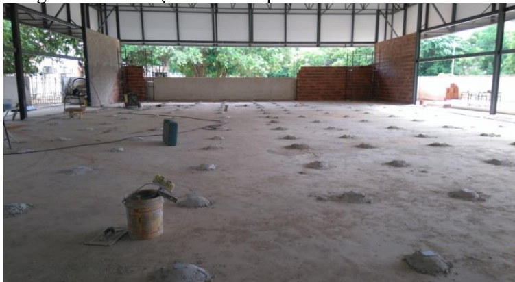
Figura 3 – Execução do contrapiso do auditório e biblioteca.
