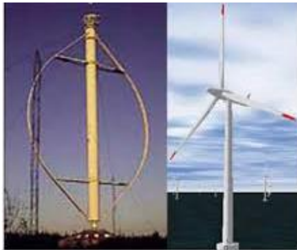
Figura 2 – Turbina eólica de eixo vertical e turbina eólica de eixo horizontal.
