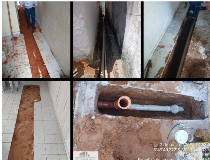
Figura 7 – Execução dos serviços de ligação intradomiciliar pela empresa LMX.
