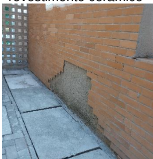
Figura 4: Descolamento de revestimento e pintura
