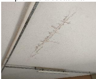
Figura 3: Manifestação de manchas por umidade
