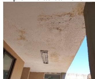
Figura 3: Manifestação de manchas por umidade
