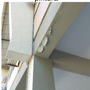
Figura 4: Descolamento de revestimento e pintura
