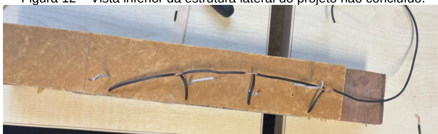
Figura 12 – Vista inferior da estrutura lateral do projeto não concluído.
