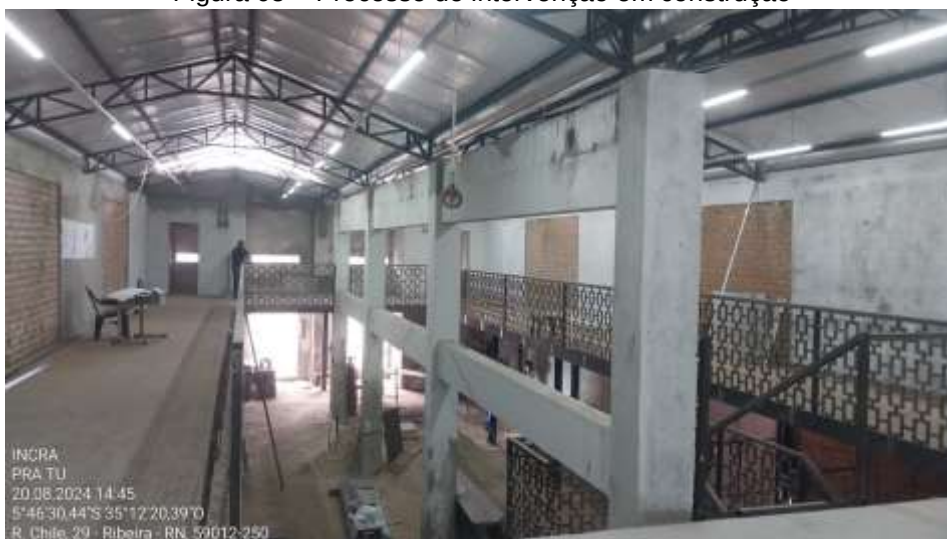
Figura 05 – Processo de intervenção em construção
