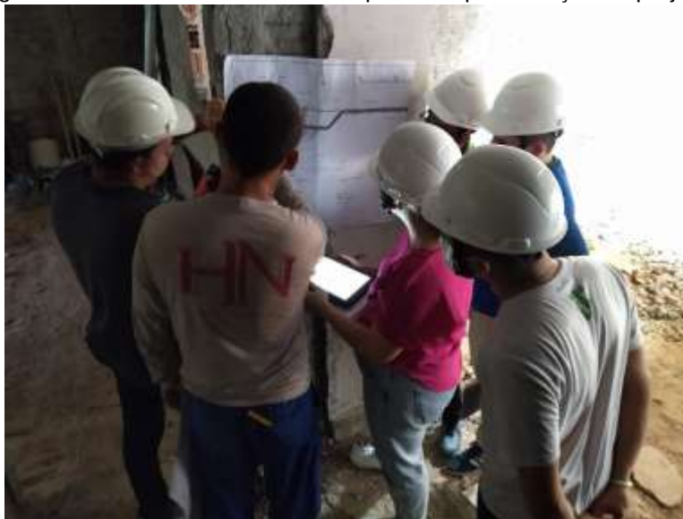
Figura 07 – Visitas técnicas ao local para compatibilização de projetos
