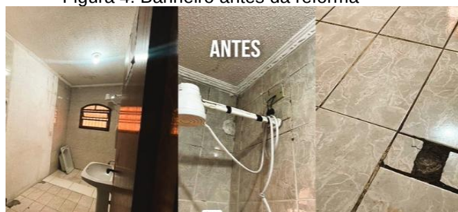
Figura 4: Banheiro antes da reforma
