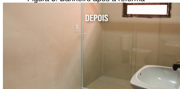
Figura 5: Banheiro após a reforma
