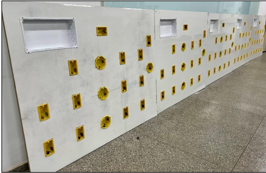
Figura 11 – Lousas com os cortes finalizados.
