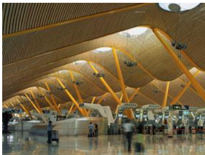
Figura 1. Terminal 4 do Aeroporto Internacional de Barajas, em Madri. Fonte: www.planetasustentavel.abril.com.br
