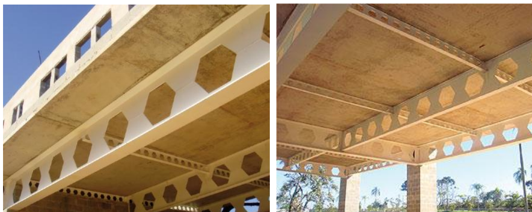
Figura 13 Vigas casteladas para sustentação de uma laje de ponte e de um pavimento ambos em concreto armado Fonte: www.cbca-acobrasil.org.br
