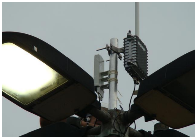
Figura 8 - Instalação do Motomesh Motorola DUO 2,4 Ghz.
