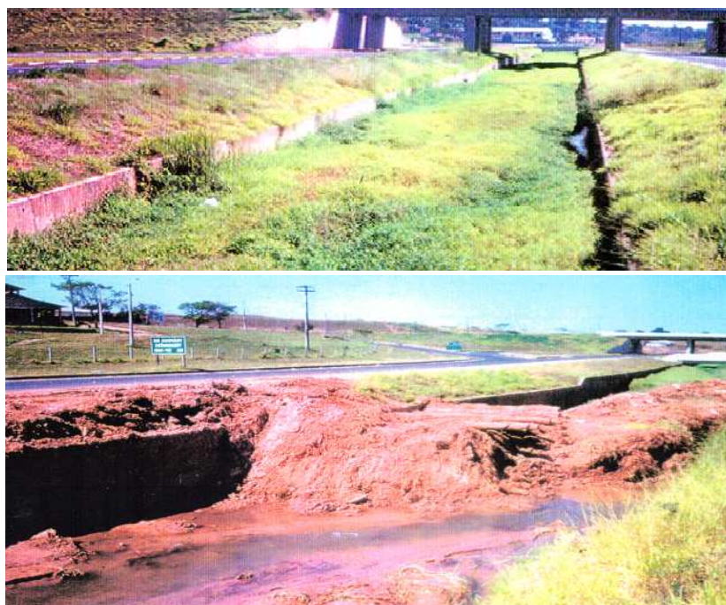
Figura 2 – Partes do trecho estudado, ribeirão Campestre – antes (acima) e depois (abaixo) de desassoreamento (Jaquiê, 1999)
