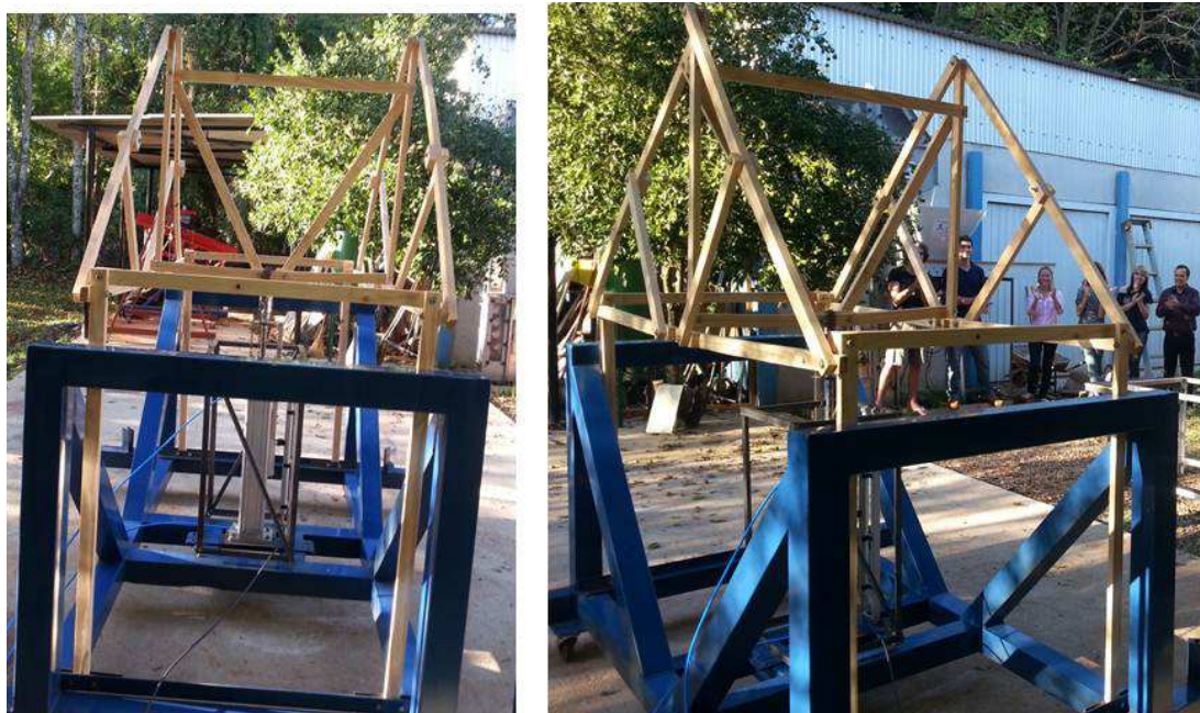
Figura 6 – Fotografia do ensaio mecânico do protótipo em madeira de uma estrutura mecânica tipo pórtico construída por estudantes de ensino médio.
