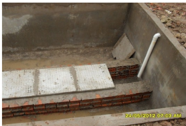
(b) montagem do sistema de distribuição afluente
