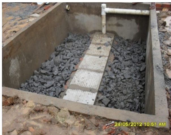
(c) colocação da camada de pedra de mão
