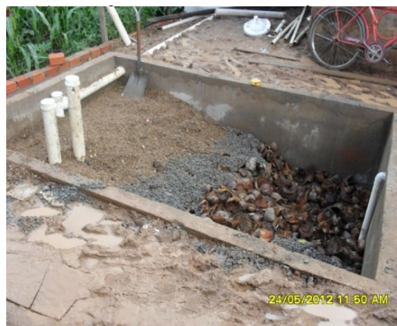
(d) colocação do material filtrante
