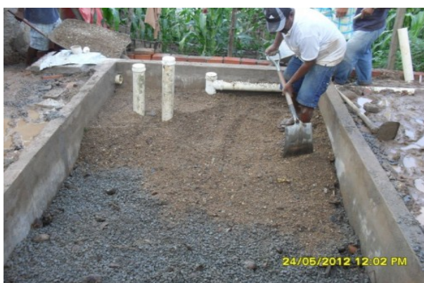
(e) espalhamento do material para posterior acomodação do solo para plantio
