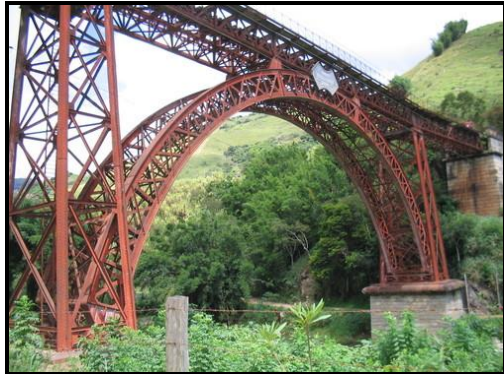
Figura 1 – Viaduto Ferroviário Paulo Fontin Fonte: http://www.panoramio.com/photo/8097279
