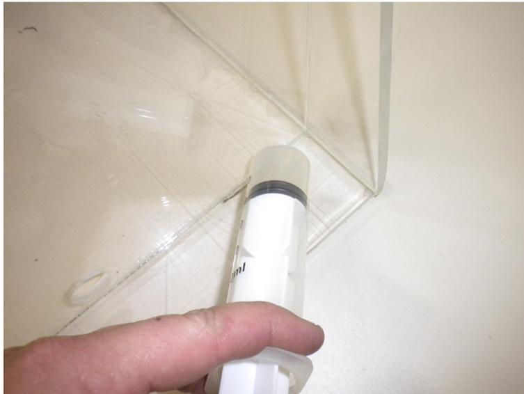
Figura 2: Aplicação do clorofórmio para solda das chapas de acrílicos.
