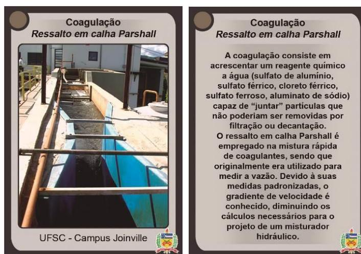
Figura 3 – Cartas do misturador tipo Calha Parshall.
