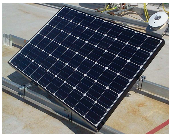
Figura 3. Parte da instalação da minirede híbrida fotovoltaica.
