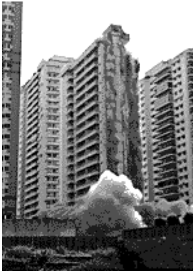
Foto 1- Implosão do Edifício Palace II
